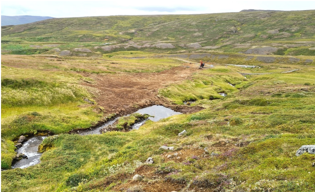
MYND 2.7 Hliðarinntak Glerárvirkjunar í Fosslæg skömmu eftir að framkvæmdum lauk. Hér sést umfang rasks og frágangur vel.
