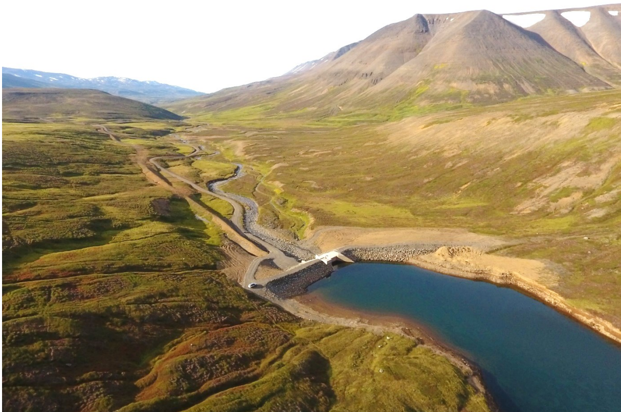
MYND 6.10 Hólsvirkjun í Fnjóskadal (6,7 MW í rúmlega 300 m.y.s.). Frágangur var sumarið 2020. Búast má við að Gilsárstífla verði sambærileg.
