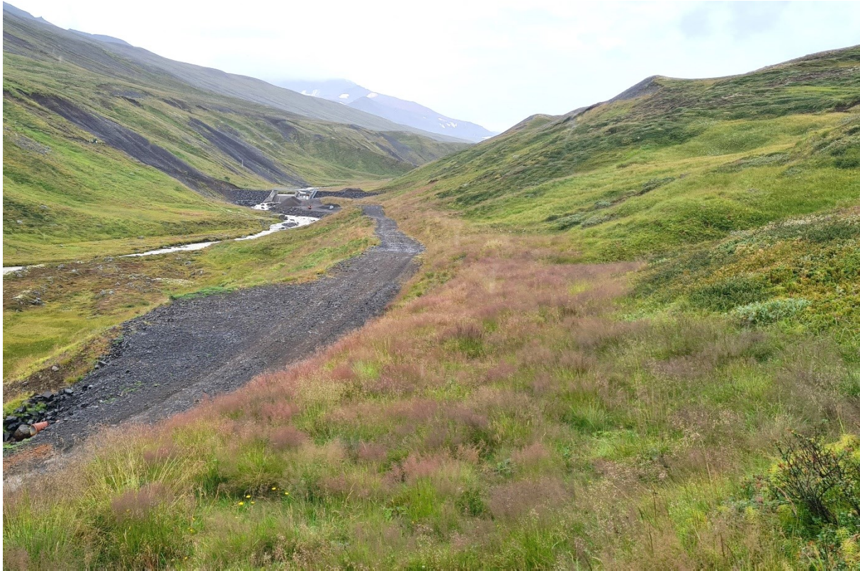
MYND 6.9 Glerárvirkjun II (3,3 MW í rúmlega 300 m.y.s.). Pípan er undir grasinu hægra megin við veginn. Frágangur var sumarið 2019 og fjórum árum seinna er alveg gróið yfir pípustæðið.
