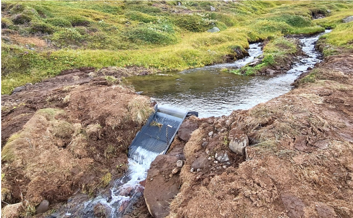
MYND 2.6 Inntaksrist í Fosslæg sem er hliðarinntak Glerárvirkjunar í Eyjafirði. Útfærslan á inntakinu verður aðlöguð að Lambadalsánum en verður sambærileg því sem má sjá á þessari mynd.
