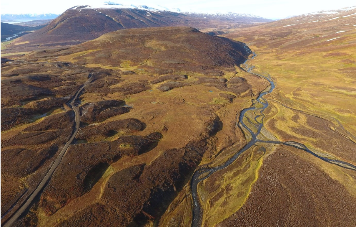
MYND 6.23 Til vinstri má sjá pípustæði og vegslóða á Hólsdal. Myndin er tekin haustið 2020 skömmu eftir að frágangi við Hólsvirkjun lauk. Búast má við sambærilegum áhrifum og frágangi við Gilsársvirkjun.
