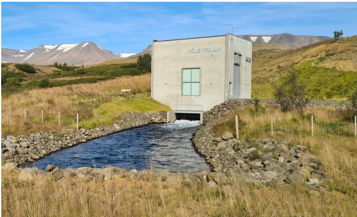
MYND 6.26 Stöðvarhús Gilsárvirkjunar verður sambærilegt stöðvarhúsi Hólsvirkjunar að stærð. Báðar virkjanir eru 6,7 MW.
