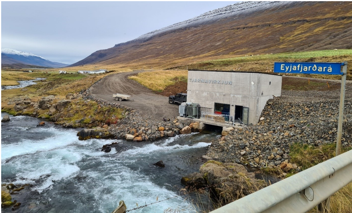
MYND 6.25 Hér má sjá stöðvarhús Tjarnavirkjunar á bakka Eyjafjarðarár. Stöðvarhús Gilsárvirkjunar verður útfært á sambærilegan hátt.
